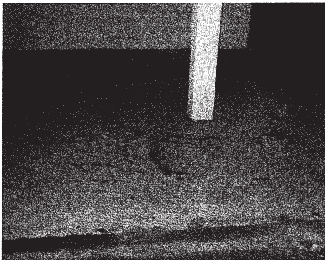
Intérieur de l'ancien local de stockage d'huiles
